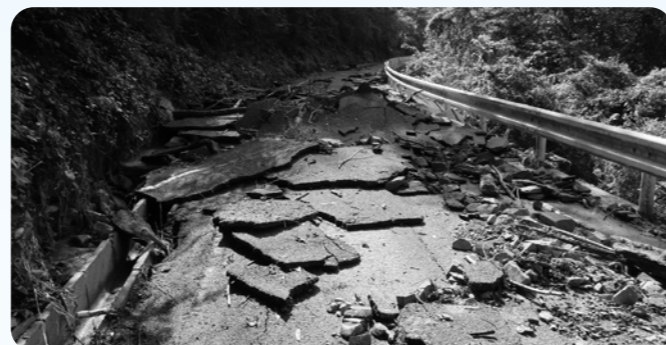
林道水無線など林業施設災害復旧 1321万円
