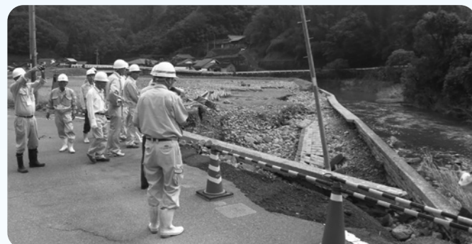
三ヶ瀬地区農地農業施設災害復旧 1150万円
