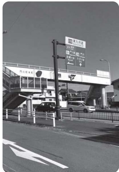
▲図書館前の歩道橋
