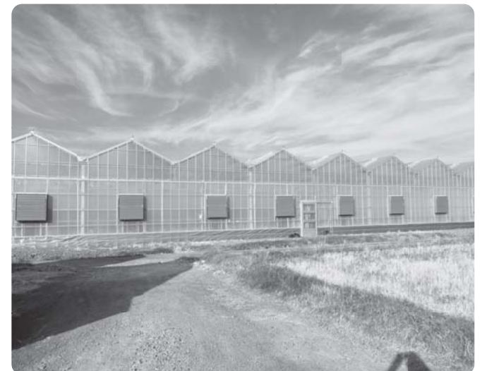
▲産地生産基盤パワーアップ事業(同型ハウスの建設)
