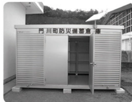
五十鈴小学校に整備した備蓄倉庫
