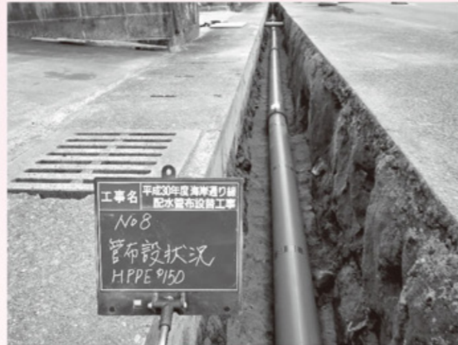
上水道配管の耐震化工事
