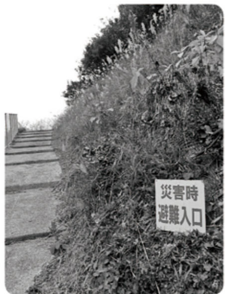
避難誘導標識
