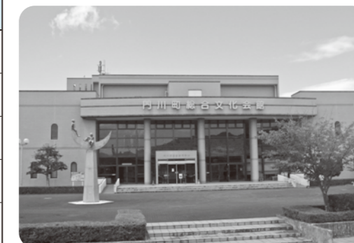
文化会館空調機器更新
