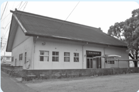
門川中学校横の武道館
