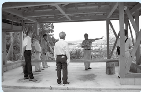
南町1区高台避難所（補助金使用例）
