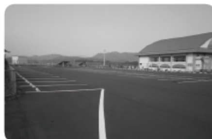
心の杜 第2駐車場（舗装完了）
