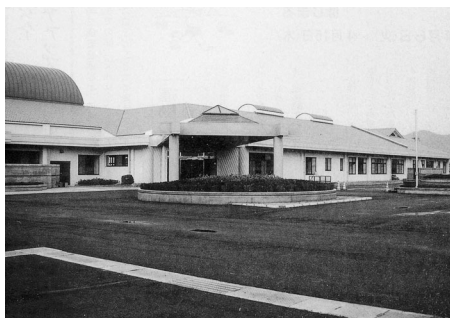
平成5年門川町総合福祉センター完成
