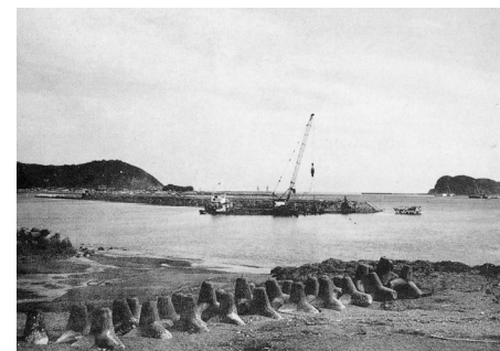
昭和55年加草海浜公園着工
