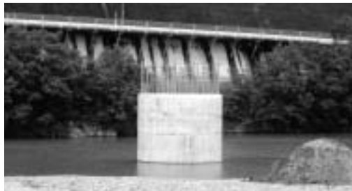
東九州自動車道小園橋脚
