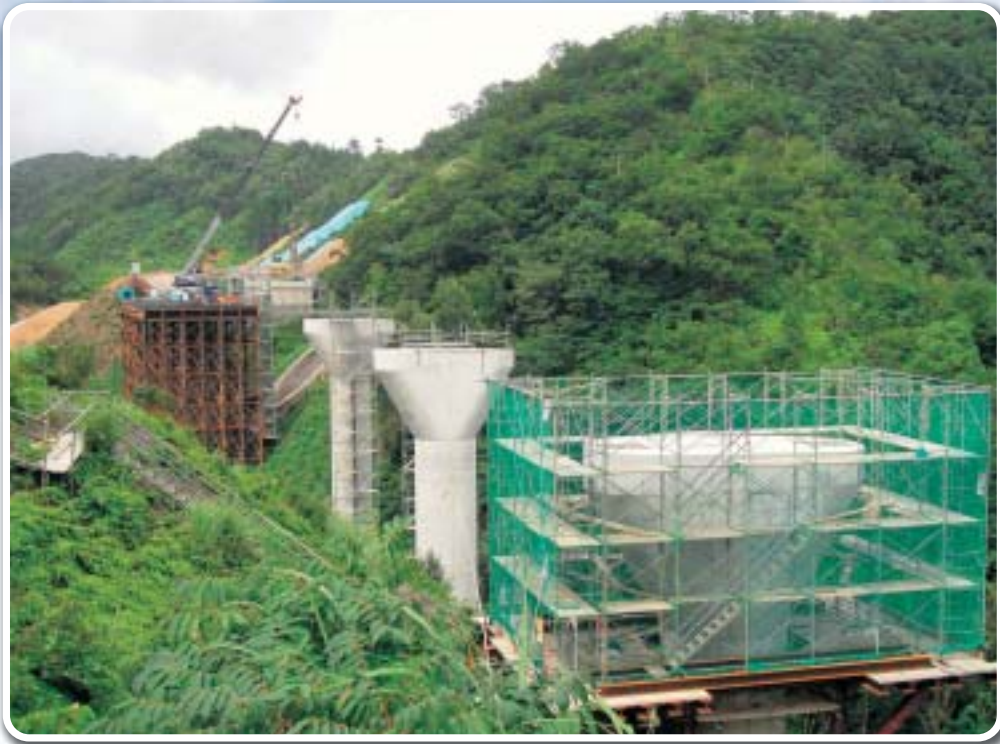
建設が進む東九州自動車道〈門川～日向間〉 (東臼杵郡町村議員視察研修)
