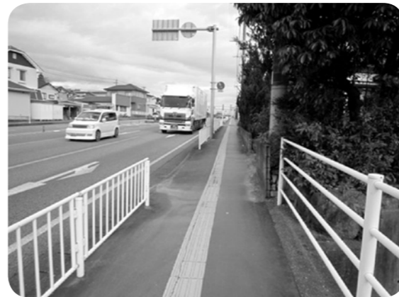
現在のガードパイプ
