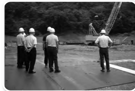
▲給食センター建設（現地調査）
