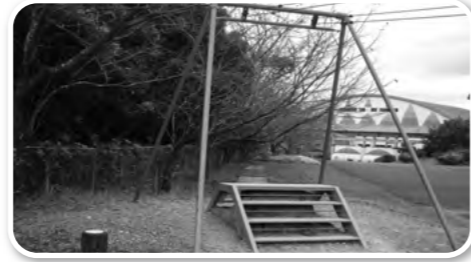
▲心の杜遊具整備（デッキ取替）
