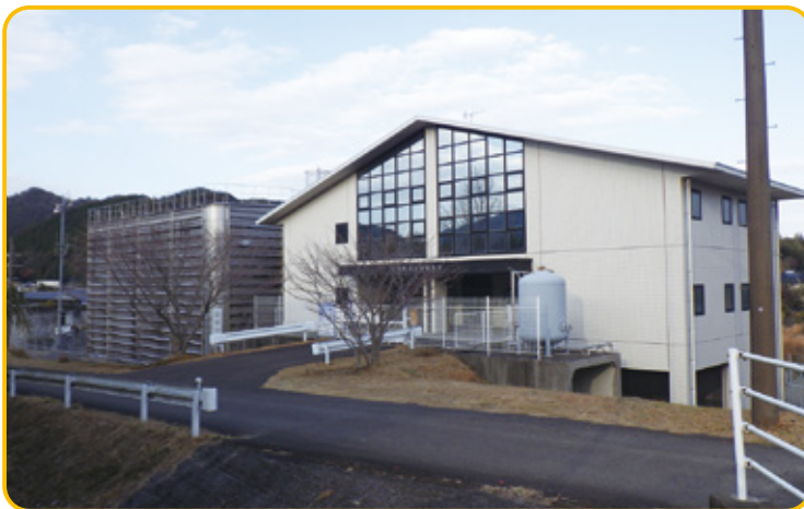
➡ じょう水場 (平成15年完成門川町)
