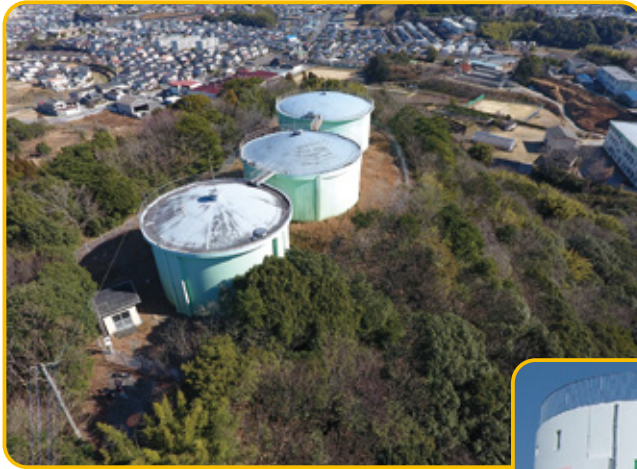
① 配水池 (門川高校の西の高台にある。)
