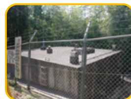
① 上井野配水池
