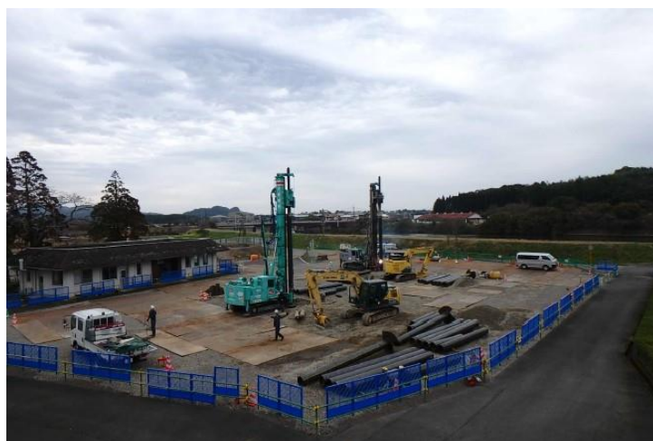
杭工事が開始されました
