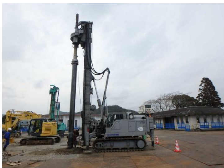
4 月末までに合計 99 か所に基礎杭が打設される計画となっています
