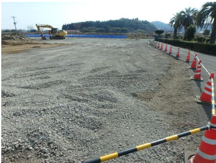
12 月に出土した埋設物の撤去工事を行いました
