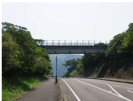
図 9 道路を跨ぐ橋梁の例（門川町管理 ふれあい橋）
