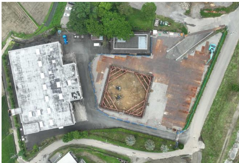
山留工事も終わり、地下階の掘削工事を行っております
