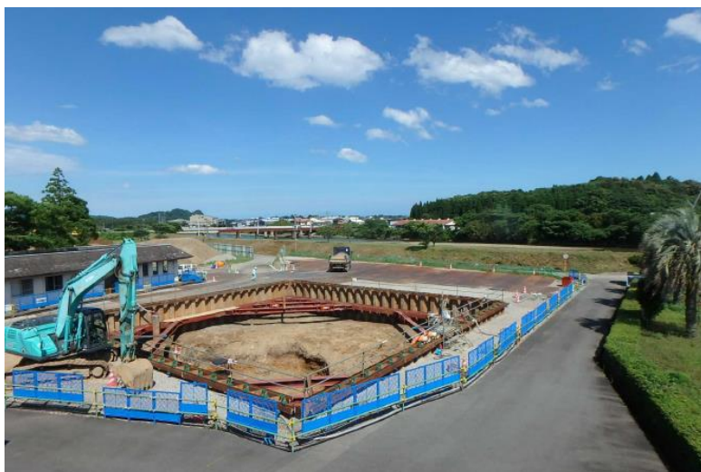
山留工事も終わり、地下階の掘削工事を行っております
