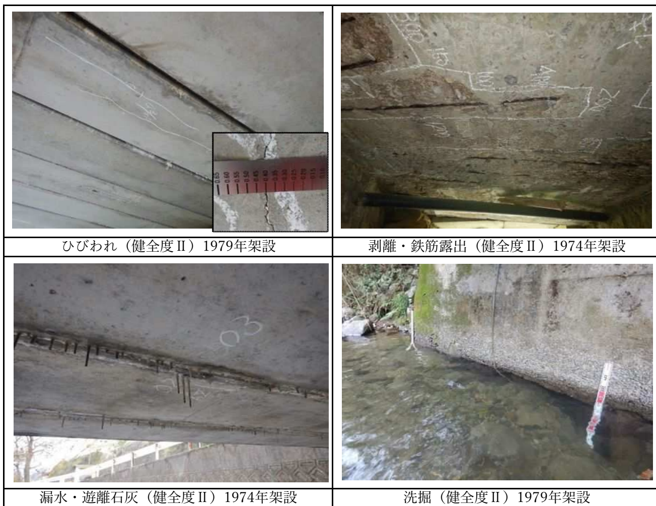
図 6 損傷状況
