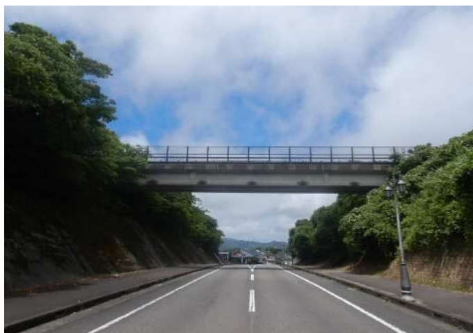
図 10 道路を跨ぐ橋梁の例（門川町管理 ふれあい橋）
