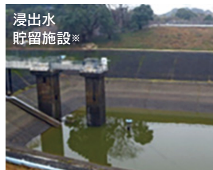
埋立物の間を通った雨水(浸出水)を一時的に貯留施設に溜め、処理施設にて国の定めた基準値以下まで処理します。
