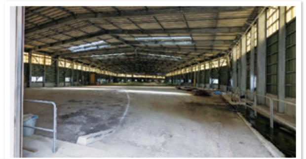
▲ 高崎処分場:左)外観、右)内部、埋立地が屋根と壁(被覆施設)で覆われています
