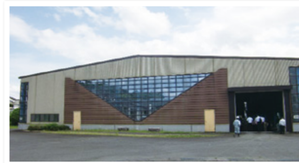
▲ 高崎処分場:左)外観、右)内部、埋立地が屋根と壁(被覆施設)で覆われています
