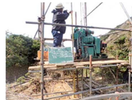
ボーリング調査
