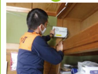
電波状況が良好であれば、希望の設置場所を確認し設置します。
