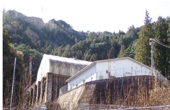
高吾北処理センター 全景
