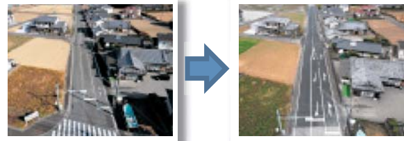
着工前 庵川西通線 完成
