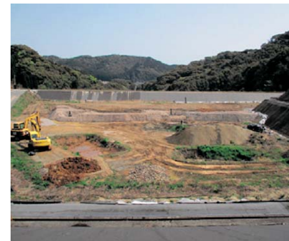
▼日向市一般廃棄物最終処分場の様子
