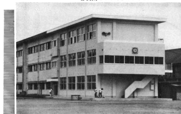
増改築された門川中学校特別教室
