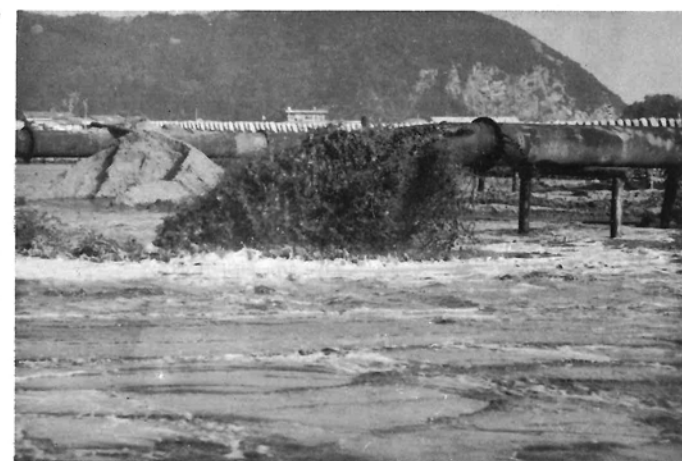
増養殖場造成改良浚渫工事とタイ・アップして造成が進む鳴子海浜総合公園埋立工事
