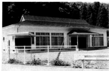
完成した大内原地区多目的集会所(①)と中山地区集落センター(②)
