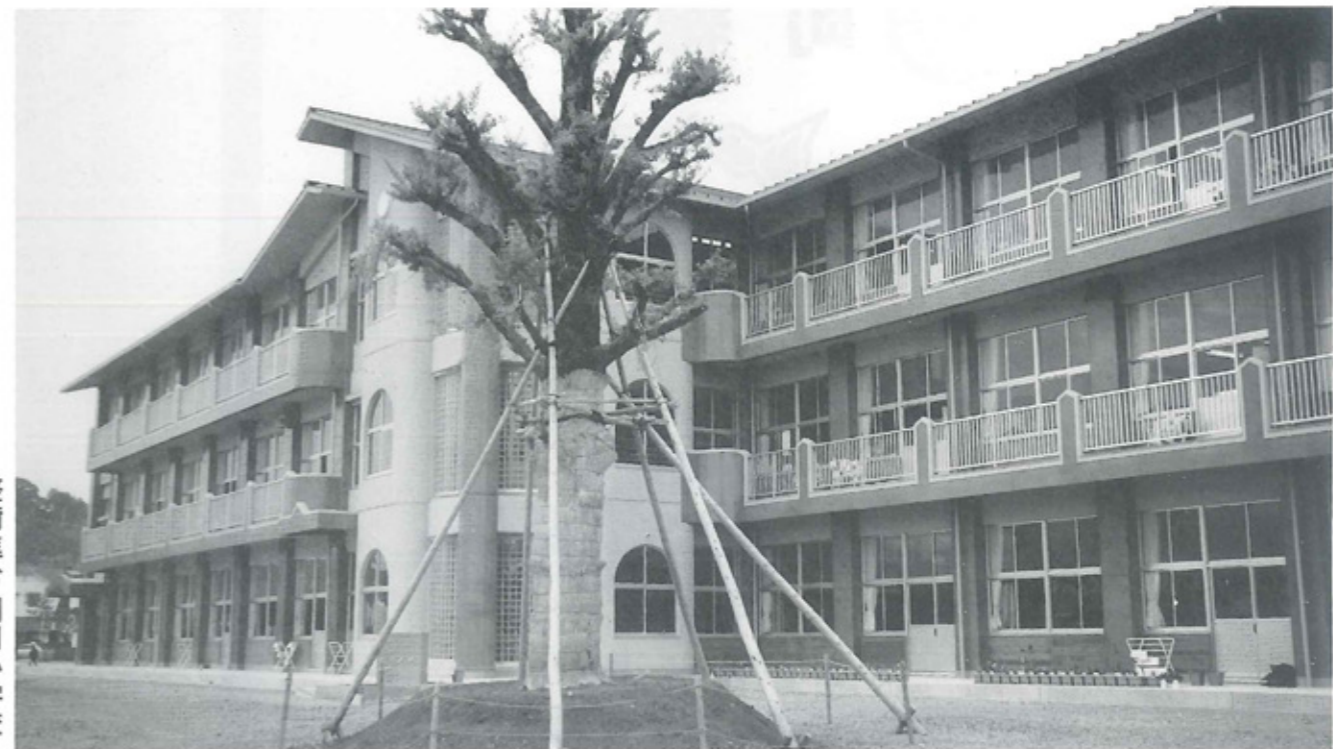
整備進む門川小学校
