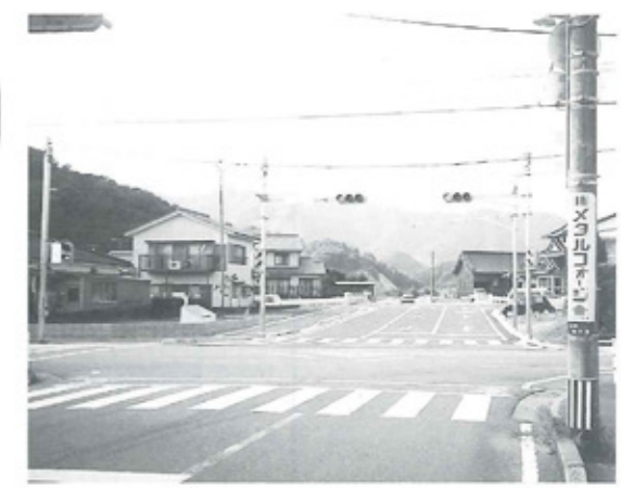
整備された竹名橋山原線道路
