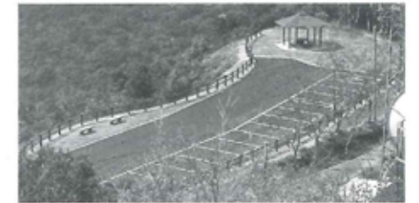
整備された遠見山駐車場(遠見山駐車場等整備事業)
