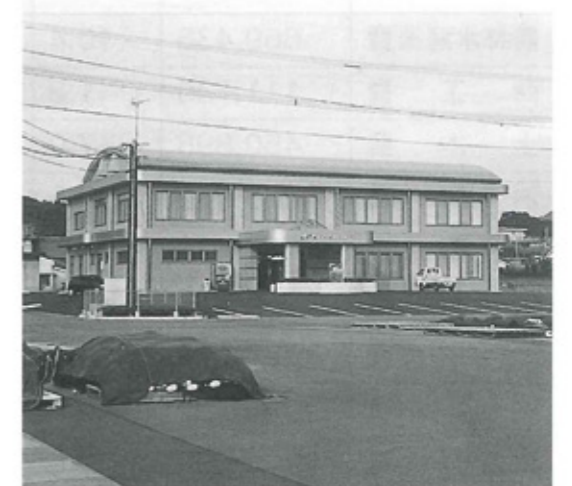
完成した庵川漁業総合管理施設 (漁業振興特別対策事業)
