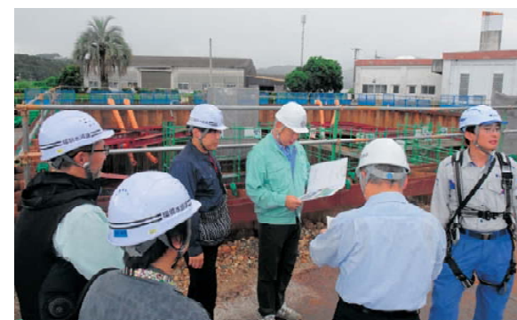
門川町次期衛生センター(仮称) 建設工事の確認
