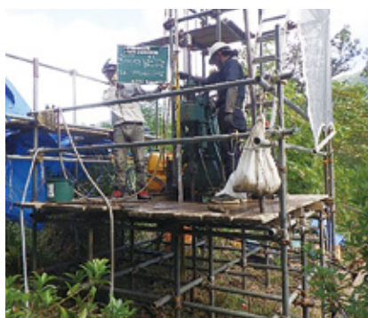
ボーリング調査
