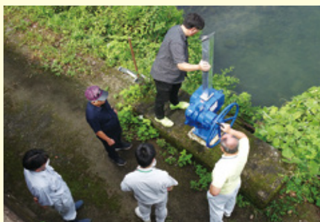
津々良井堰バルブ取替工事の確認
