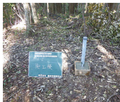
観測井戸設置
