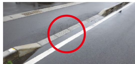
正しい施工例
