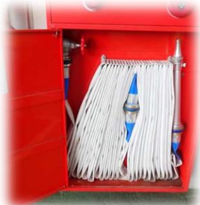
消火栓設備内
