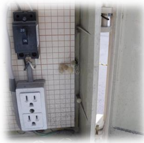
電源ボックス内
