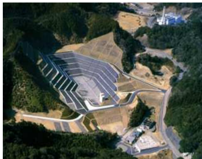
日向市一般廃棄物最終処分場
